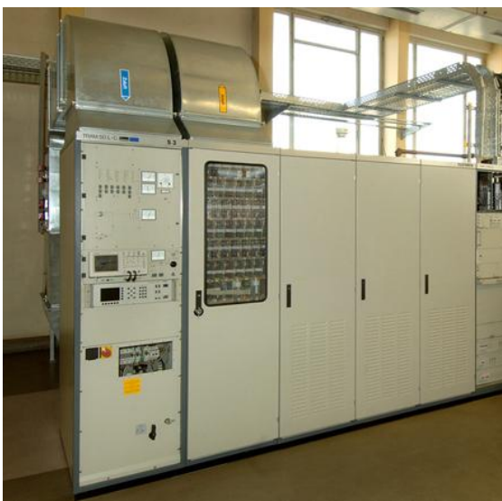
Abbildung 2 DCF77 Halbleitersender (aus [9])
